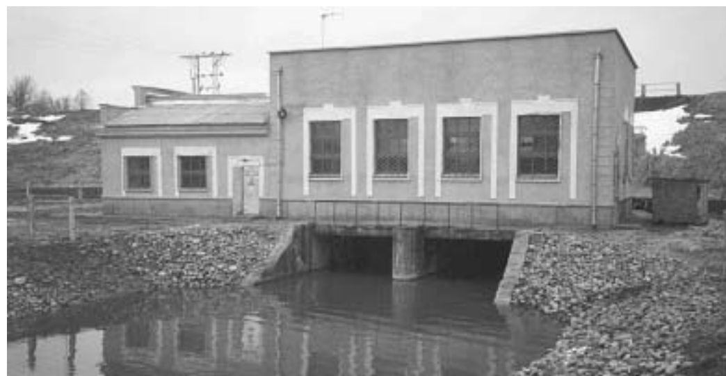
Здание Лукомальской ГЭС, Беларусь
