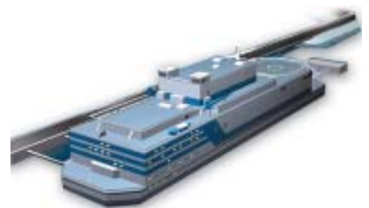
Плавучая атомная электростанция ПАЭС-600 с реактором ВВЭР-300. Мобильный энергоисточник с реакторной установкой на базе освоенных судовых технологий для целей электроснабжения и опреснения. Электрическая мощность 2x295 МВт, тепловая мощность 2x850 МВт
