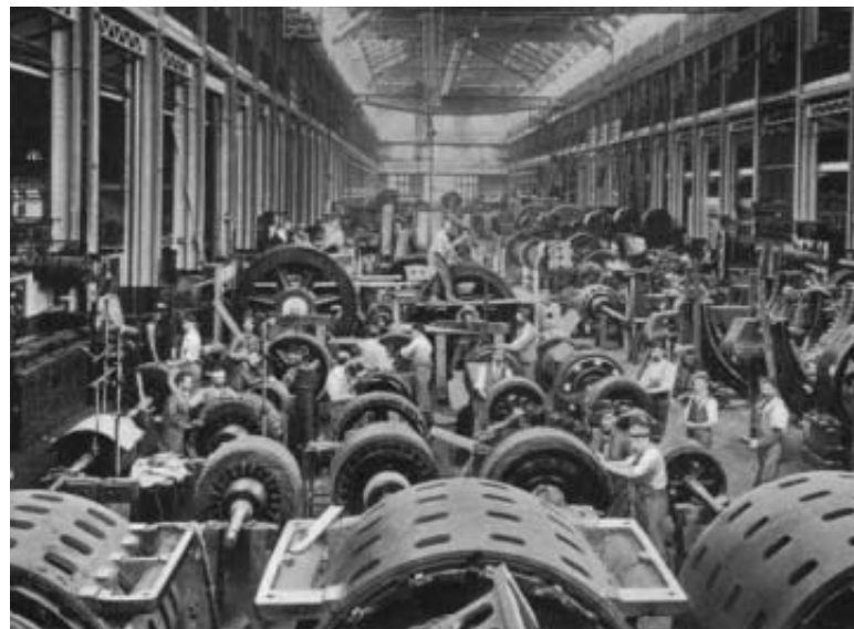
Рис. 2. Обмотка крупной вращающейся и неподвижной арматуры (Westinghouse)
