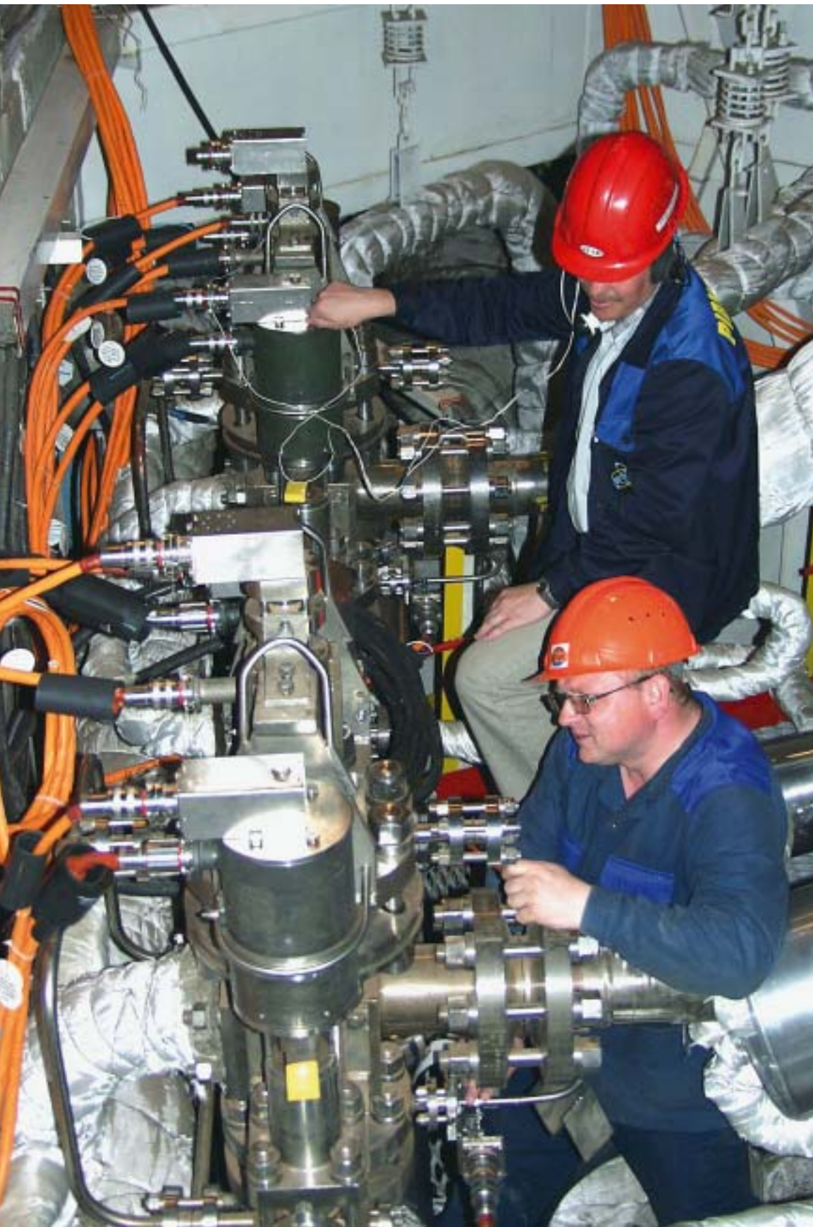
Идет модернизация энергоблока № 2 Хмельницкой АЭС
