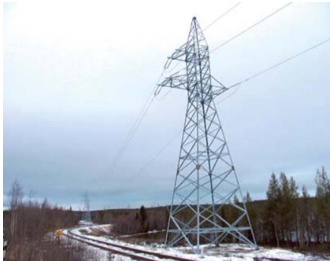
ЛЭП-110 Кольской АЭС. Генпродрайчик – Кольское монтажное управление ГЭМ, которое выиграло конкурс на проведение этих работ. Длина ЛЭП – 9 км.
