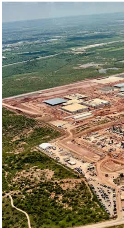
Строительство объекта инфраструктуры OpenAI, SoftBank и Oracle
